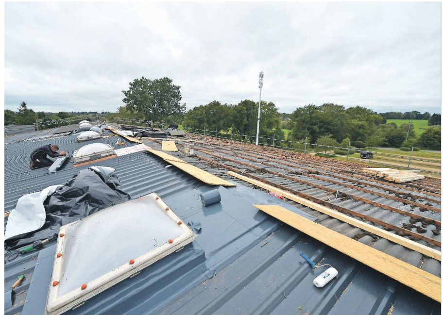
Statikprobleme haben den Eingriff an dem - ohnehin in die Jahre gekommenen - Dach der Ketteniser Mehrzweckhalle erforderlich gemacht. Anwohnern, wie auch der Stadt Eupen bereitet die Baustelle Kopfschmerzen. Fotos: David Hagemann
